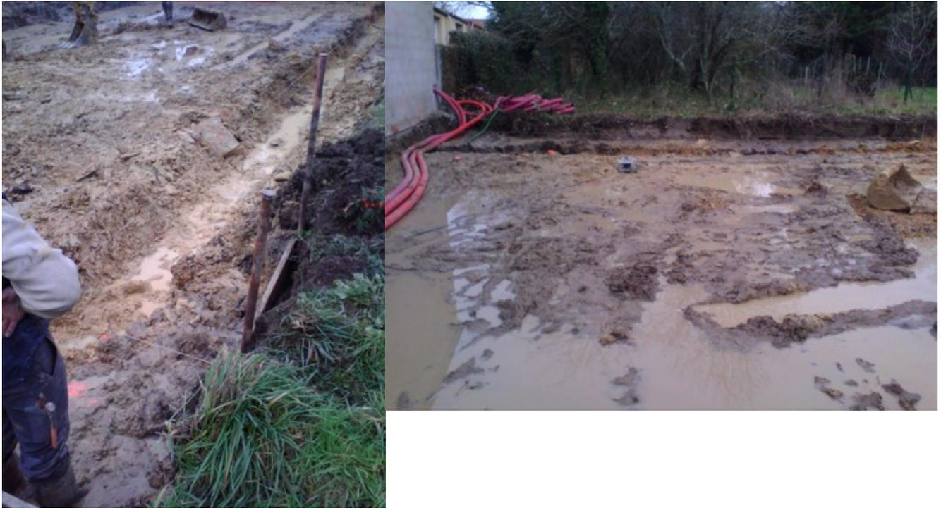
*Préparation du hérisson sous dallage et fondations en maçonnerie.*
